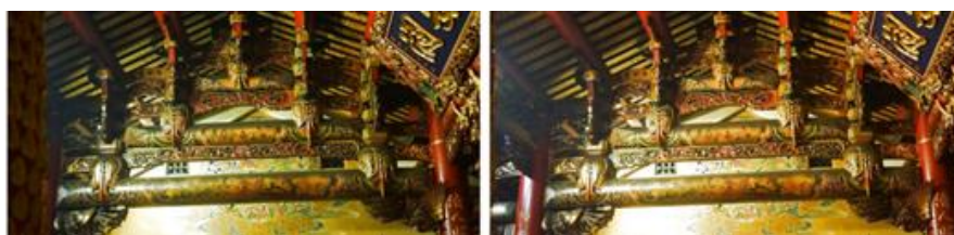
圖 3 豐原慈濟宮正殿三通五爪棟架
