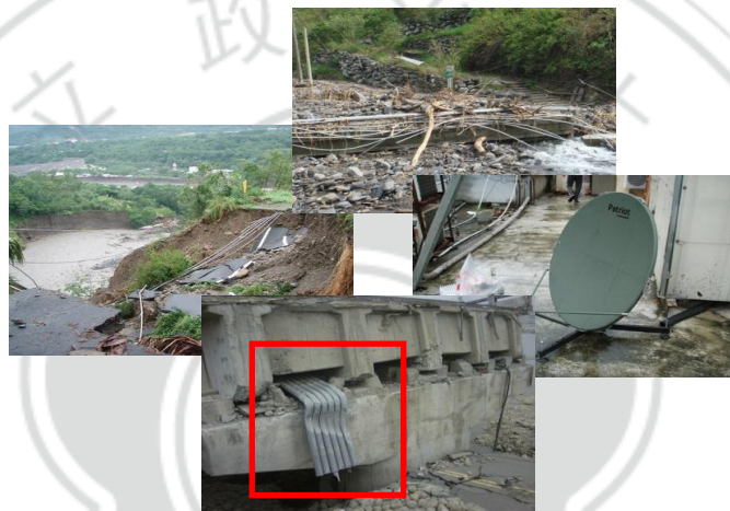
圖 1、通訊線路與設備於災害中受損
