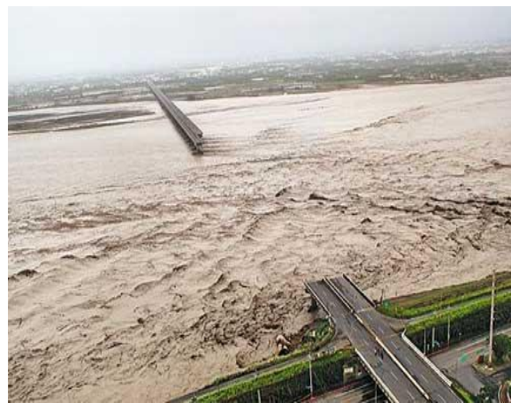
圖 2、八八水災中橋樑遭洪水沖毀
