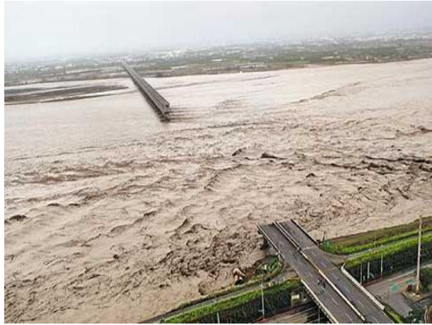
圖 2 大型天然災害中斷裂的橋梁
