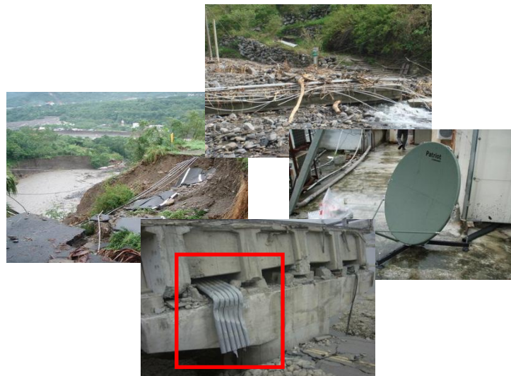
圖 1-1、通訊線路與設備於災害中受損
